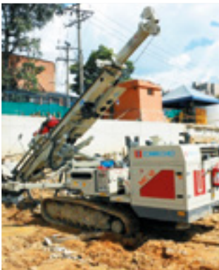
Equipos de Perforación
